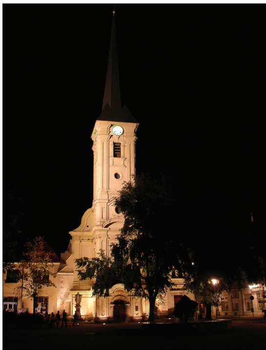
Obr. 3. Katolícky kostol Celkové osvetlenie kostola je zabezpečené výbojkovými svietidlami c a DecoSceene a je navrhnuté tak, aby neoslňovalo a nerušilo obyvateľov bývajúcich v okolí kostola. Vstupná časť kostola a príľahlé časti sú osvetlené svietidlami DecoSceene zabudovanými do zeme. Celková rovnomernosť osvetlenia fasády sa dosiahla osvetlením bočnej a zadnej časti kostola svietidlami s asymetrickou krivkou svietivosti DecoSceene.
