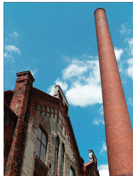
Obr. 4. Elektrárň v Poprade
